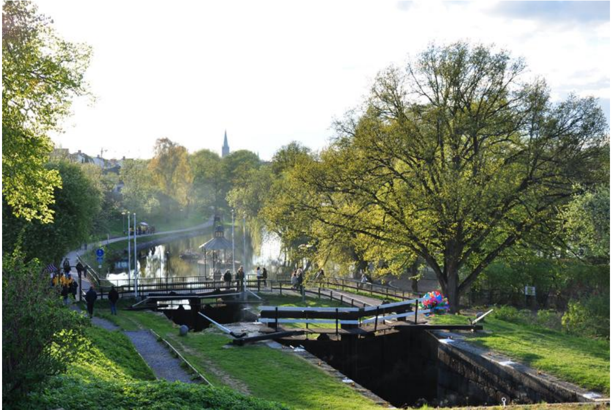
Skymningen är nära
